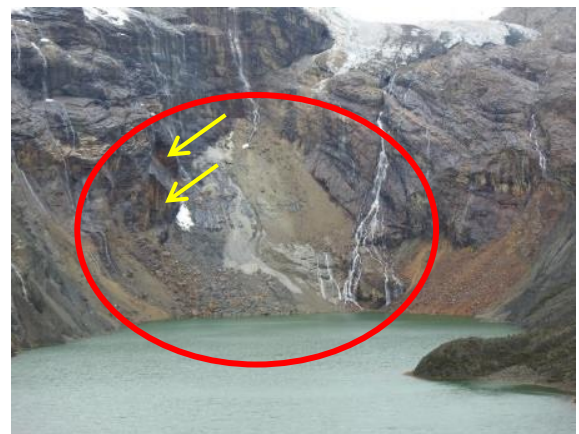
Fotografía N° 03: Lado Posterior de la laguna Tullparaju, aquí se puede observar los puntos de desprendimiento y roca desintegrada sobre el hielo reconstituido - febrero 2017.
