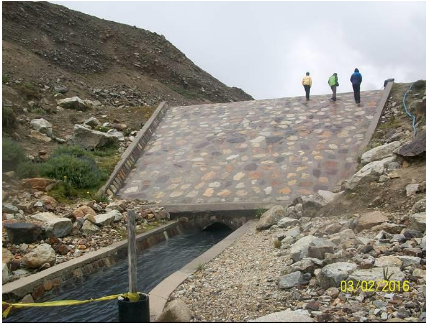
Foto N° 05: Vista del talud aguas arriba de la Presa de seguridad.
