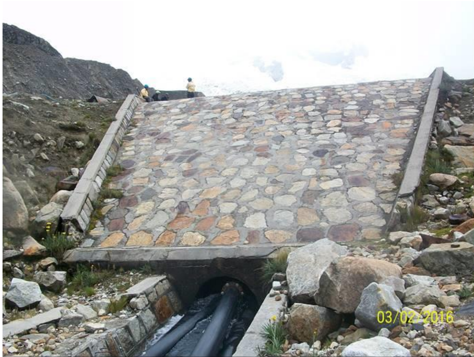
Foto N° 07: Vista del talud aguas abajo de la Presa de seguridad
