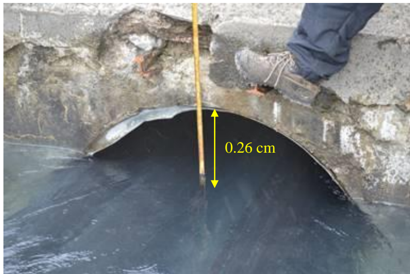
Foto N° 04: Se muestra el nivel del agua de la Laguna Palcacocha en la entrada del conducto de descarga (26 cm de pelo libre)
