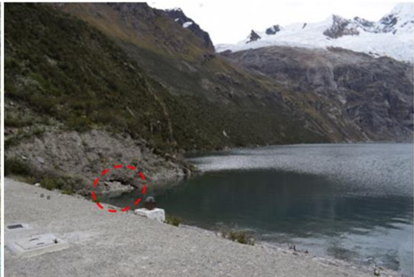
Fotografía N°5: Deslizamientos de material morrénico en el flanco derecho de la laguna Rajucolta, se observa los muros construidos para evitar deslizamientos que afecten al dique de la obra de regulación.
