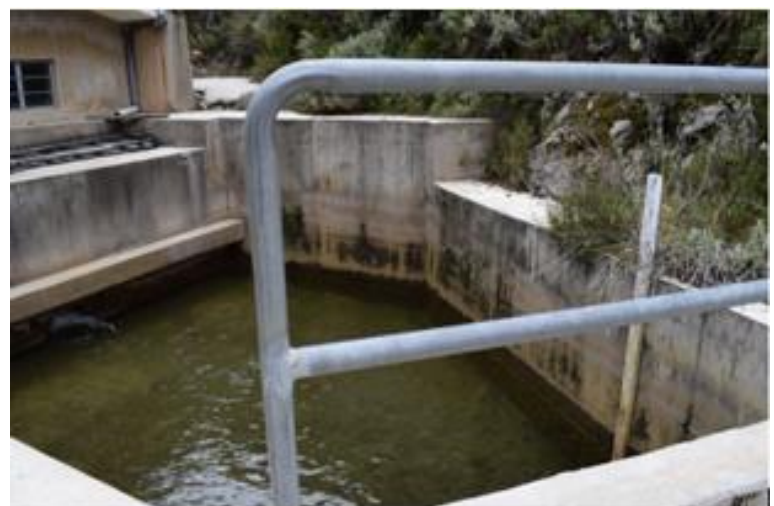
Fotografía N°10: Estructura de desfogue de agua de la laguna Rajucolta.
