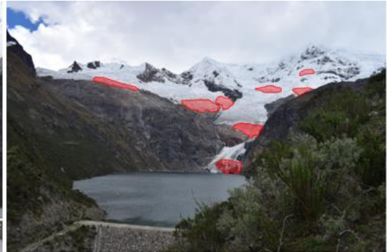
Fotografía N°2: Muestra algunos glaciares colgantes con probabilidad de desprendimiento hacia la laguna Rajucolta, se puede observar también el nivel de espejo del agua es muy cercano al del dique.
