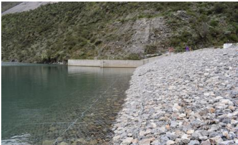
Fotografía N°8: Se observa la estructura del dique en contacto con la laguna Rajucolta, no se observa ningún cambio en la infraestructura.
