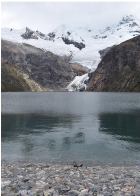
Fotografía N°9: Se observa la estructura de regulación y el dique con la laguna.
