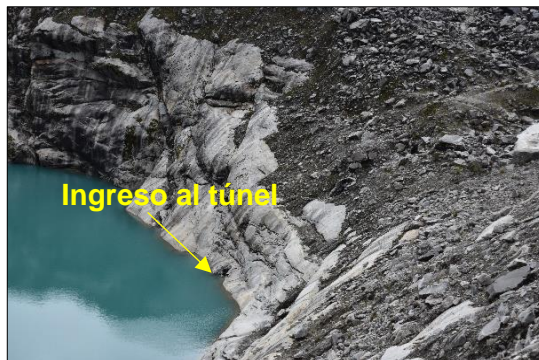
Fotografías N° 6 y 7: Túnel de desagüe como obra de seguridad ante impactos de avalanchas que ocasionarían oleajes y el desbordamiento de la laguna 513.
