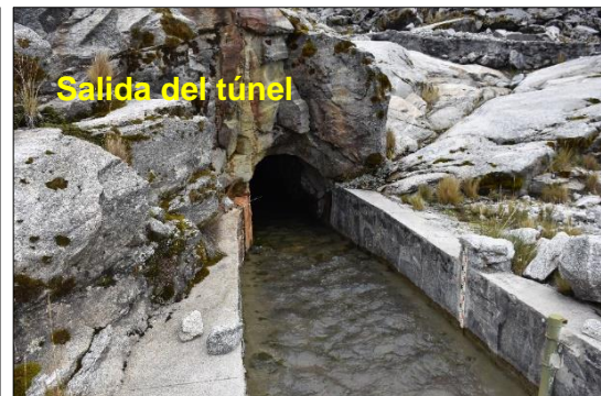
Fotografías N° 6 y 7: Túnel de desagüe como obra de seguridad ante impactos de avalanchas que ocasionarían oleajes y el desbordamiento de la laguna 513.
