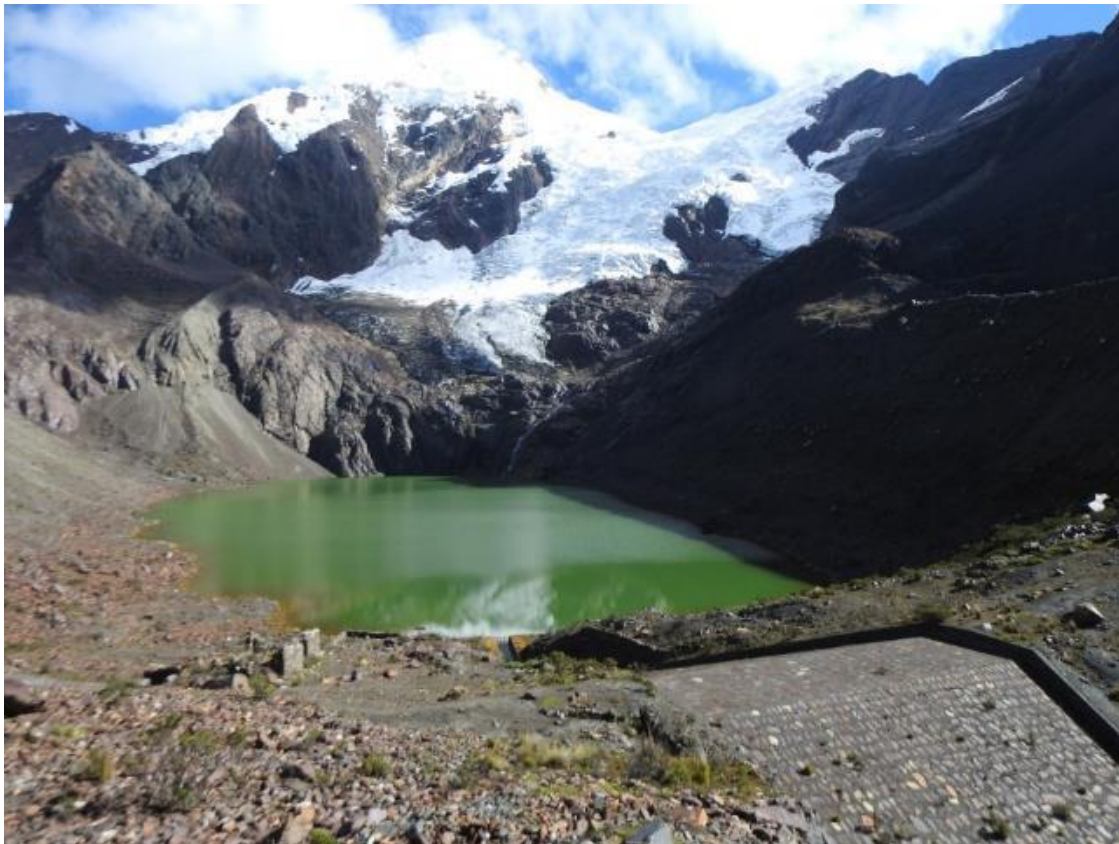
Fotografía N° 01: Vista panorámica de la Laguna Cuchillacocha, aquí se observa que el vaso de la laguna se encuentra en estado normal.
