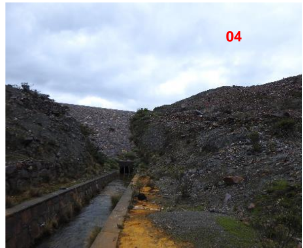
Esta imagen muestra la parte interior del dique de seguridad con presencia de algunas vegetaciones
