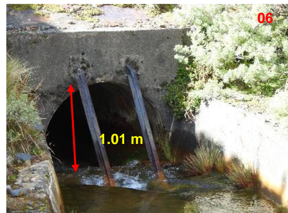
Aquí se muestra el ingreso al conducto y la altura medido, desde la parte superior del conducto hasta el nivel de agua
